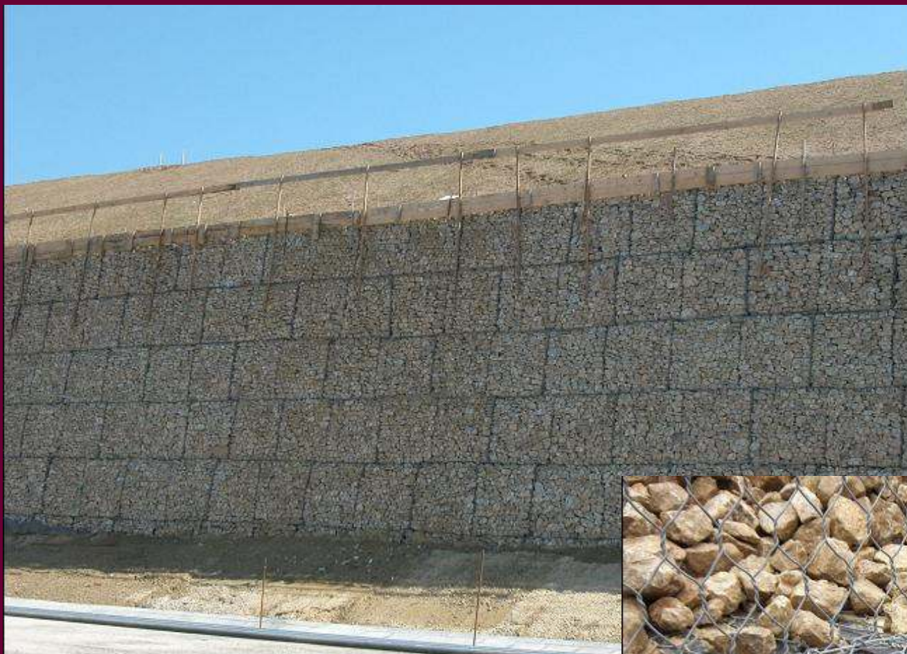
M7 autópálya Bszárszó - Ordacsehi Terra-Mesh támfal Pannon-Freyssinet
