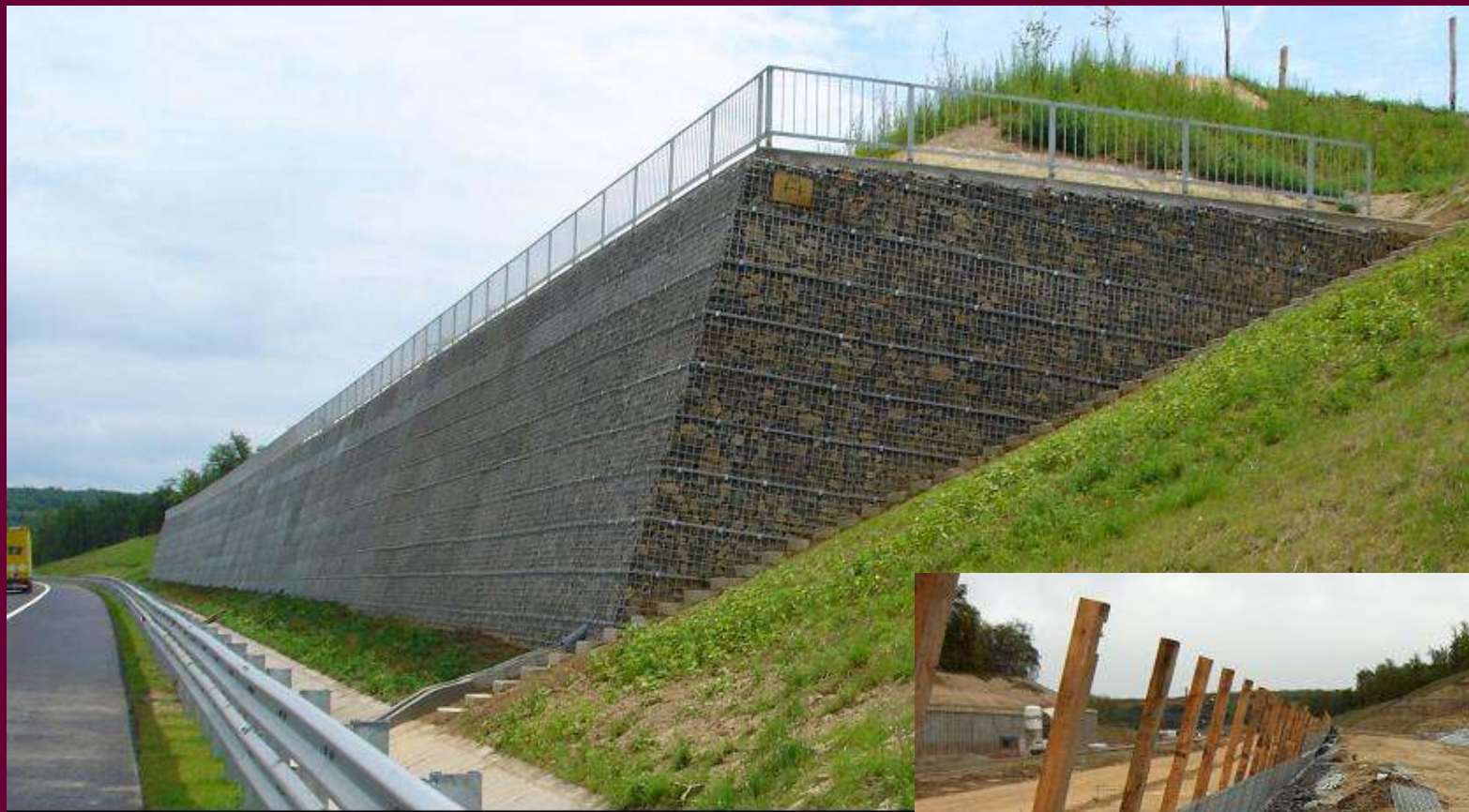
M7 autópálya Bszárszó - Ordacsehi Terra-Trel támfal Pannon-Freyssinet
